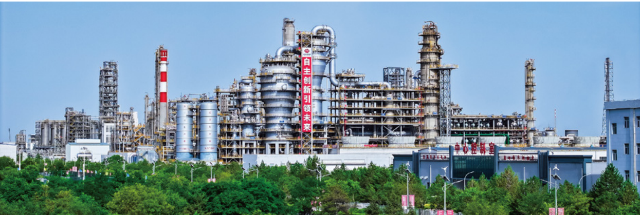
世界首套、国家级 60 万吨 / 年煤制烯烃示范工程——包头煤制烯烃示范项目
