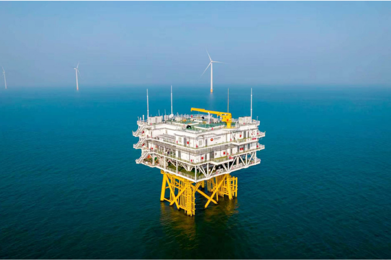
国华投资半岛南 U2 场址海上风电项目荣获 2025 年度中国电力优质工程
