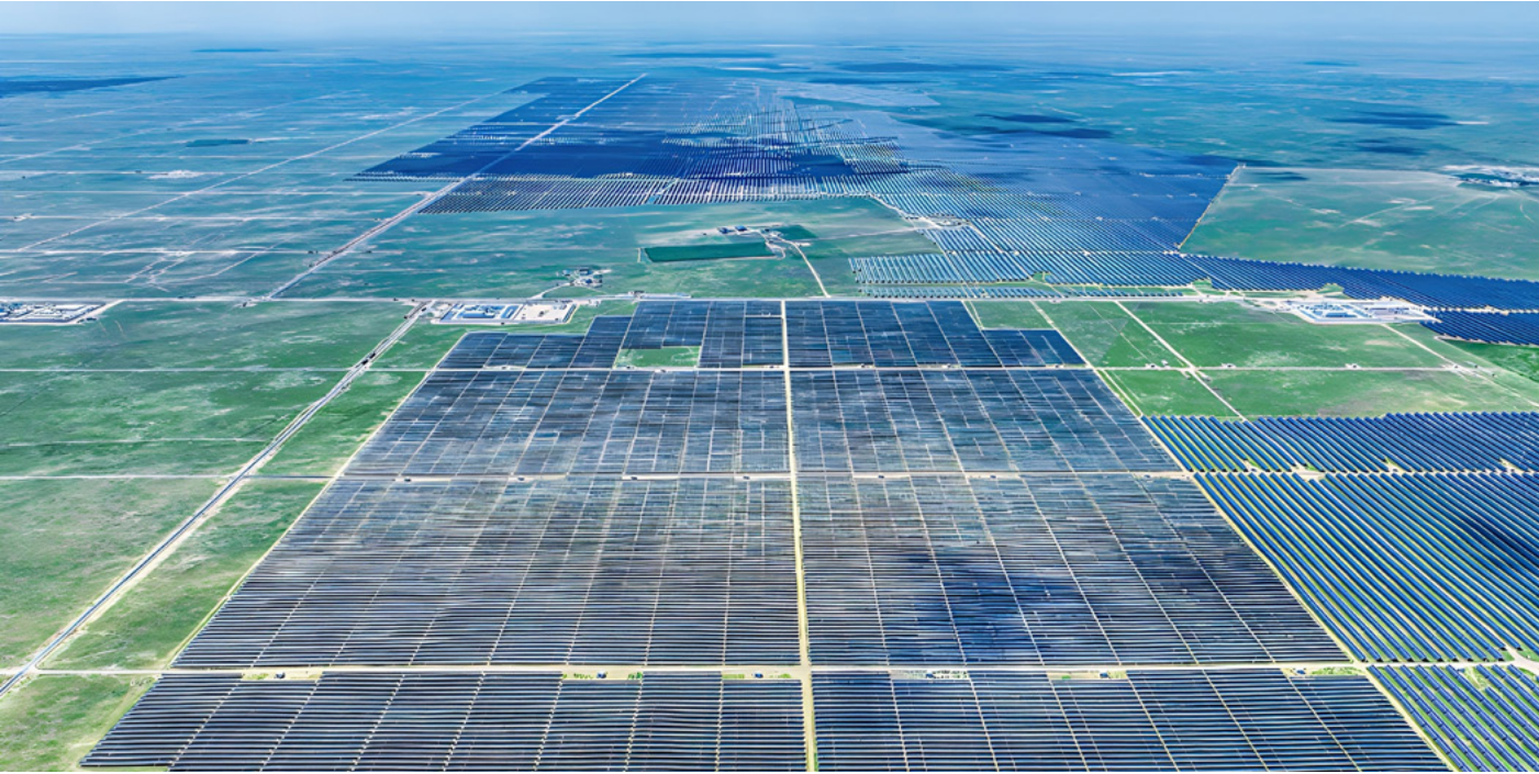
国电电力蒙西蓝海光伏电站
