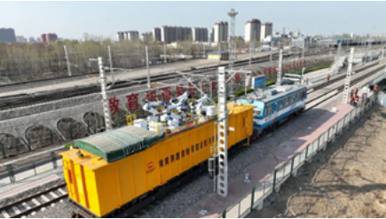
2025 年 3 月，朔黄铁路牵头研发的接触网智能检修机器人平台上线试运行，是我国电气化铁路接触网领域首个实现“智能诊断—自主决策—精准作业”全链条闭环的智能运维装备
