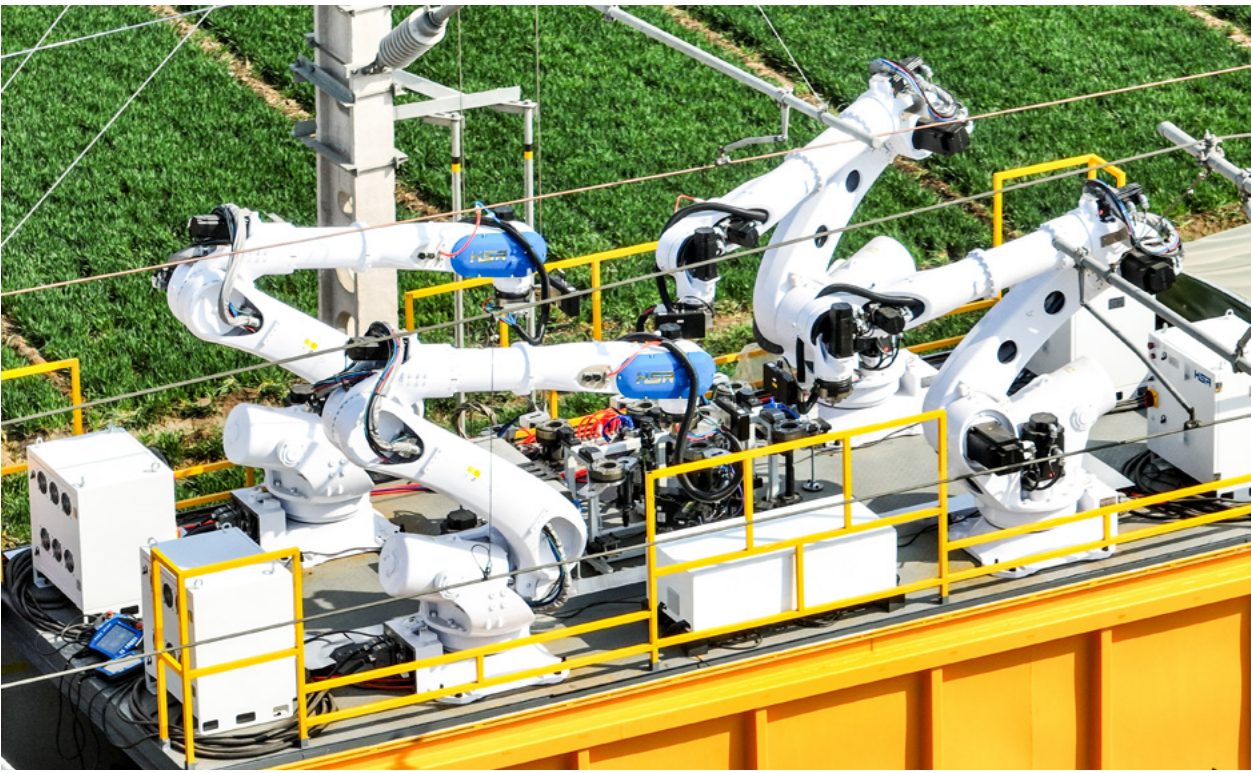
朔黄铁路接触网智能检修机器人平台
