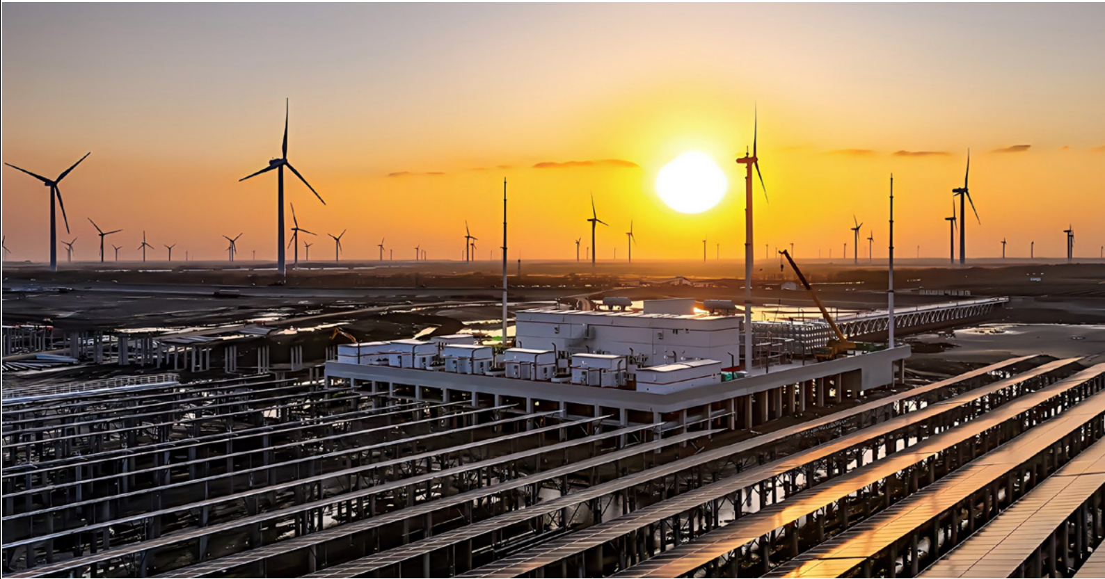
国华投资江苏如东“光氢储一体化”海上光伏项目
