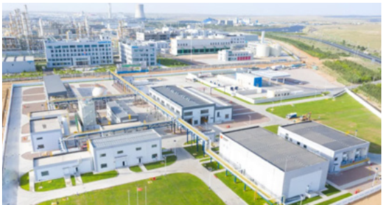
国家能源局首批能源领域氢能试点项目——国能宁东可再生氢碳减排示范区一期项目
