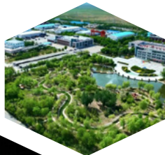
宁夏煤业金凤煤矿
