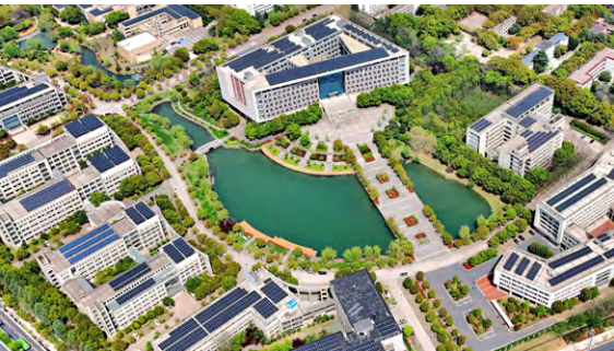
马鞍山公司安徽工业大学校园光伏发电站每年可供应绿电约 700 万千瓦时，年减碳量达 4950 吨，减排二氧化硫 950 千克
